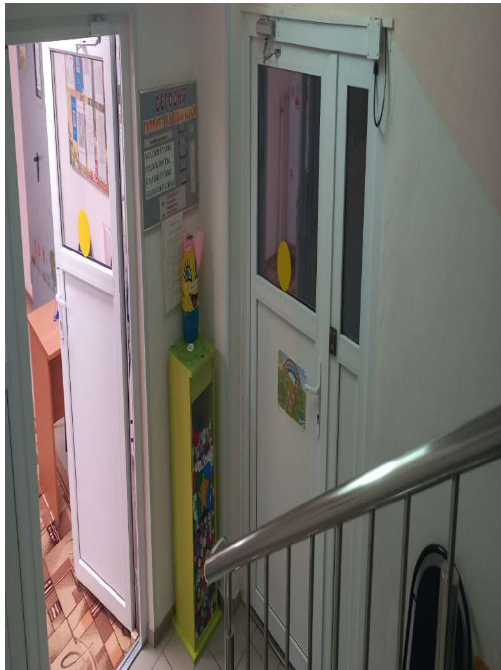
Фото 22. Зона целевого назначения здания
