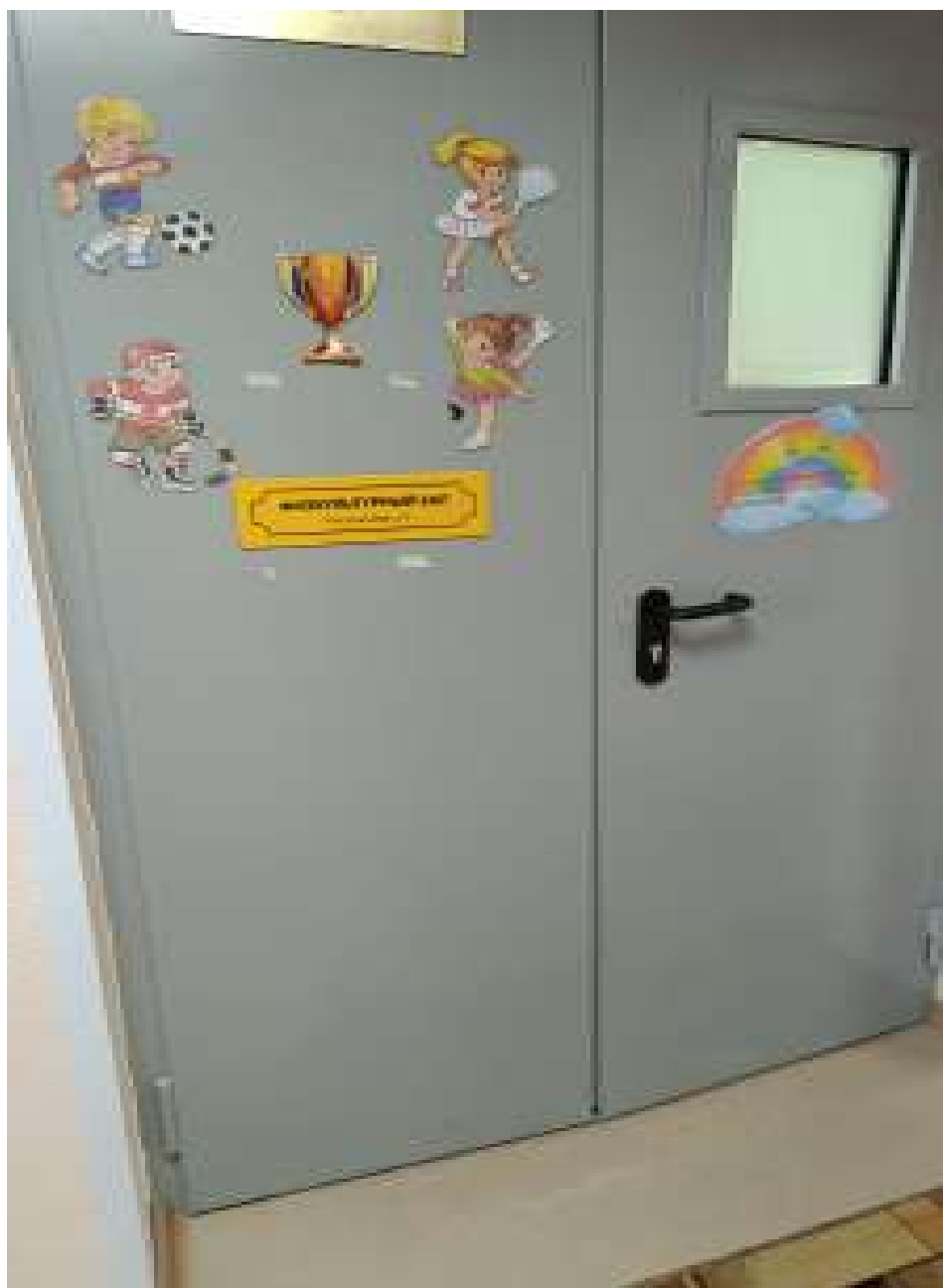
Фото 25. Тактильная вывеска физкультурного зала
