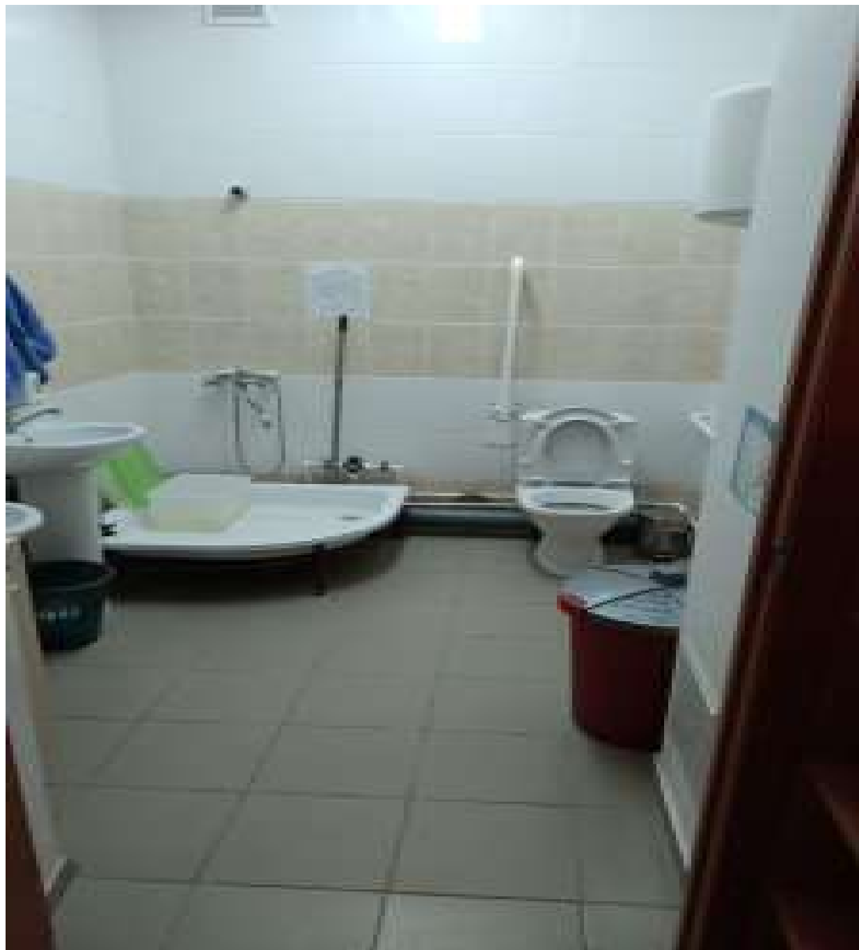
Фото 33. Санитарно - гигиеническое помещение
